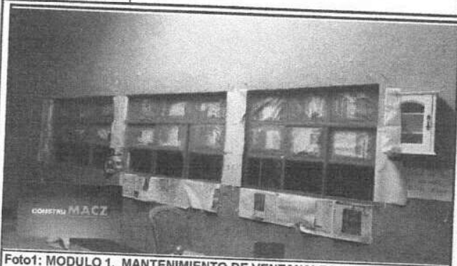
Foto 1: MODULO 1. MANTENIMIENTO DE VENTANALES DE METAL
