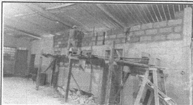
Foto 1: MODULO 1. AULA, SUSTITUCION DE PARED DE MADERA POR BLOCK
