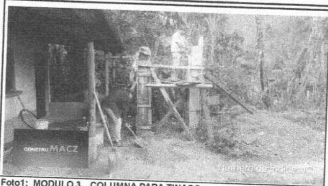
Foto 1: MODULO 3. COLUMNA PARA TINACO.
