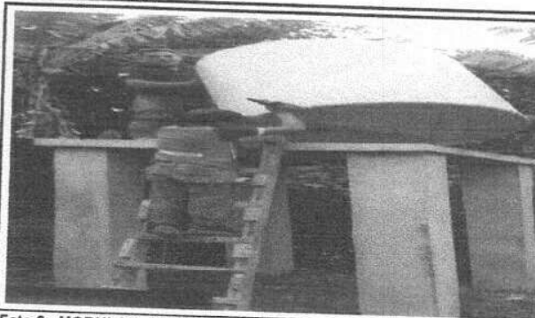
Foto 2: MODULO 3. BASE DEL TINACO
