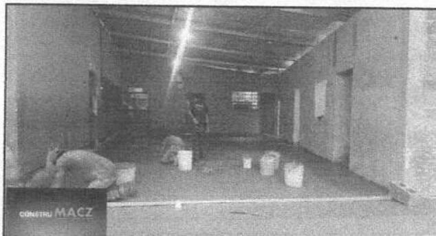
Foto 4: MODULO. REPARACION DE PLANCHA DE CONCRETO DE PATIO
