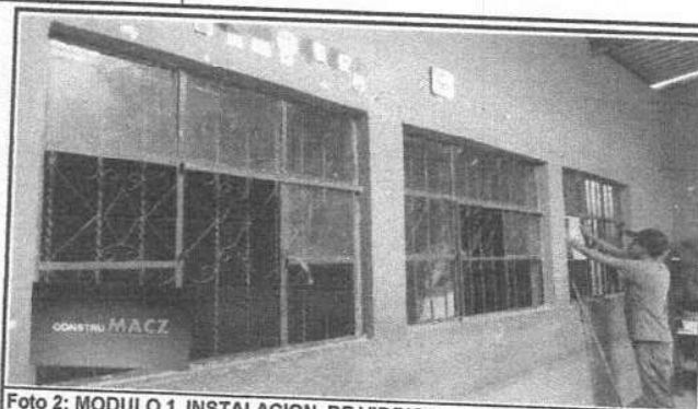
Foto 2: MODULO 1. INSTALACION DE VIDRIOS
