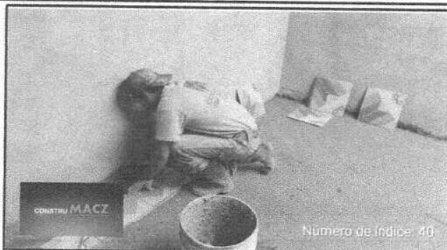
Foto 2: MODULO 1. INSTALACION DE PISO CERAMICO EN EL AULA.
