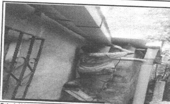
Foto 4: MODULO 1. INSTALACION DE BAJADA DE AGUA PLUVIAL EN LAPARTE DE ATRÁS DE LA ESCUELA.
