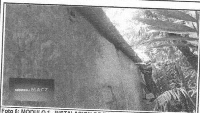
Foto 5: MODULO 1. INSTALACION DE BAJADA DE AGUA PLUVIAL DE METAL
