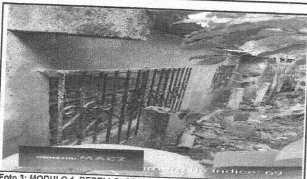
Foto 3: MODULO 1. REPELLO, CERNIDO DE MURO DE AULA INTERIOR Y EXTERIOR
