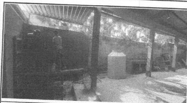
Foto 6: MODULO 2. REPELLO Y CERNIDO DE MURO DE CONTENCIÓN INTERIOR Y EXTERIOR
